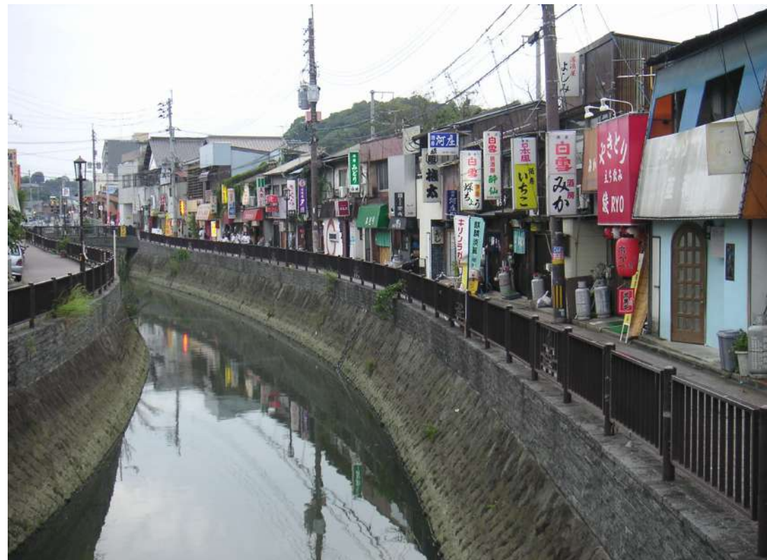
所在地: 八幡西区堀川町 (折尾駅東口横)
